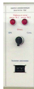
Лицевая панель блока БПЧ2 (на 2 насоса)
