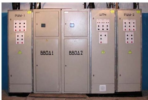
Щит ЩУ-ЧЭ на ЦТП – слева направо шкафы: РШУ-1, ВРУ-1, ВРУ-2, ШПЧ, РШУ-2
